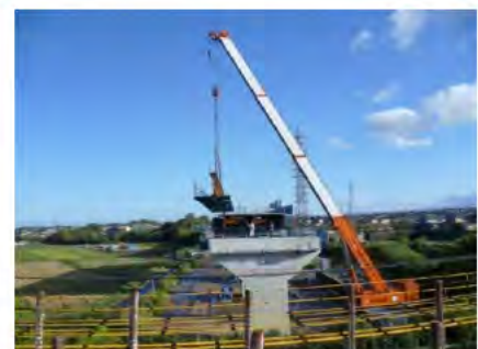
クレーン架設
