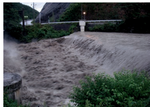
飯島堰堤(流入部の状況)
