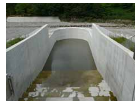
三峰川バイパス出口の状況 (8月17日) (放流後約1ヶ月)
