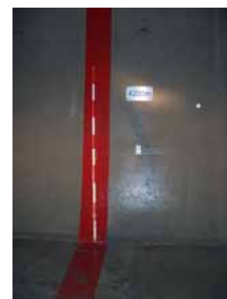
三峰川バイパス内部の状況 (7月20日) (放流終了直後)
