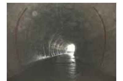
三峰川バイパス内の状況
