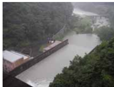
⑤美和ダム下流(放流中の状況)
