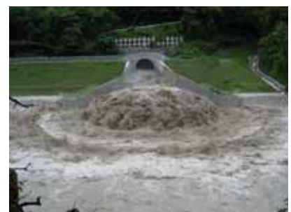
⑥三峰川バイパス放流水 (放流中の状況)
