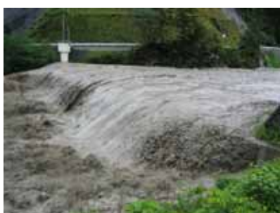
①飯島堰堤(流入部の状況)
