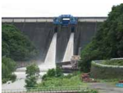
④美和ダムゲート(放流中の状況)
