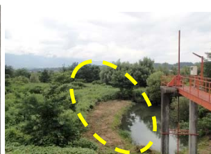
樋門と澁筋の間の水路
