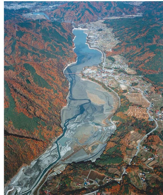
上流から見た堆砂状況(平成11年11月)
