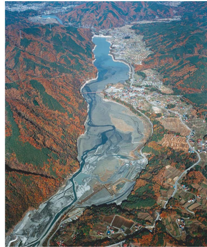
上流から見た堆砂状況(平成11年11月)
