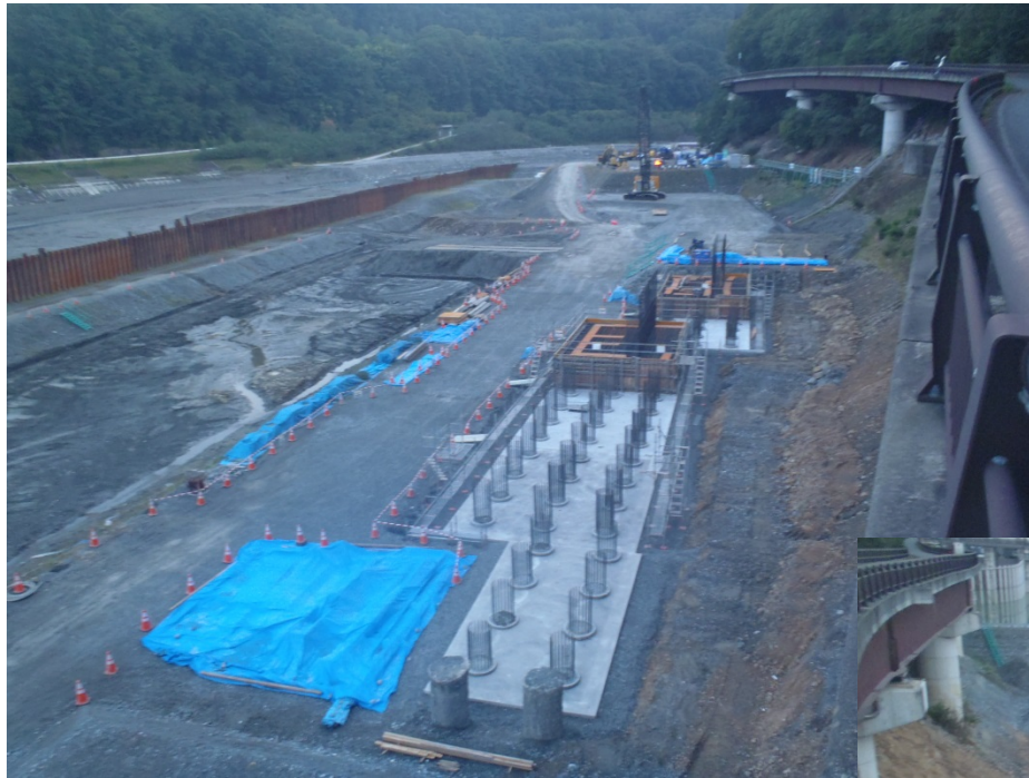
分派堰より上流を望む(2016/10/07)
