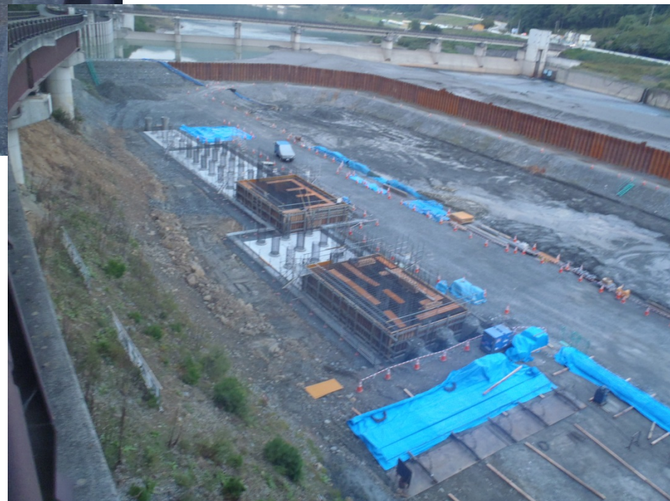
左岸道路より下流を望む(2016/10/7)
