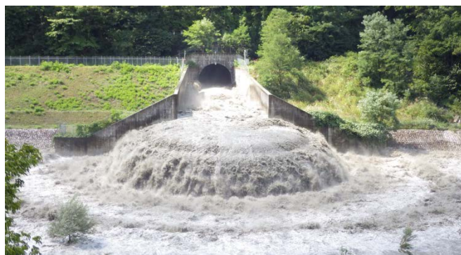
上：上流から見た美和ダム堆砂状況（平成 11 年 11 月） 下：土砂バイパス運用時のトンネル吐口（平成 30 年 9 月）
