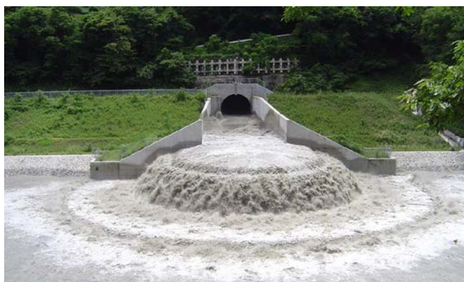
上：美和ダム貯水池堆砂状況（平成11年） 下：土砂バイパストンネル吐口（平成19年）
