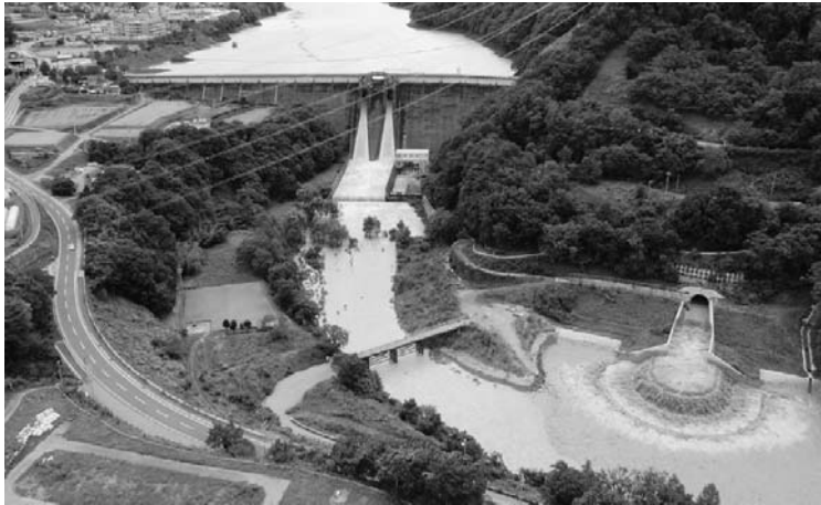
平成19年9月洪水時の試験運用の状況 (美和ダム下流からダム本体、土砂バイパス施設吐口を望む。)
