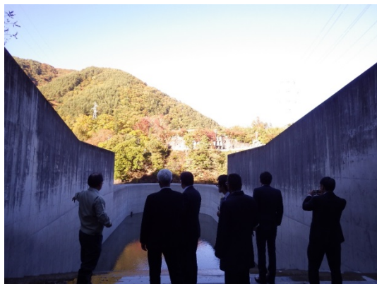
土砂バイパストンネル
