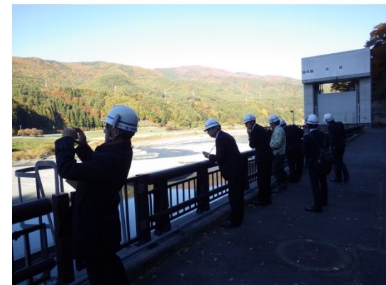
湖内堆砂対策施設 (ストックヤード)
