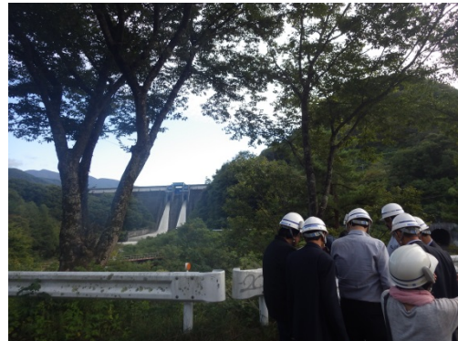
バイパストンネル吐口
