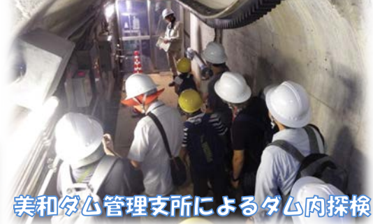
美和ダム監査廊
