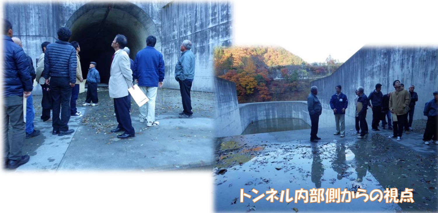
土砂バイパストンネル吐口
