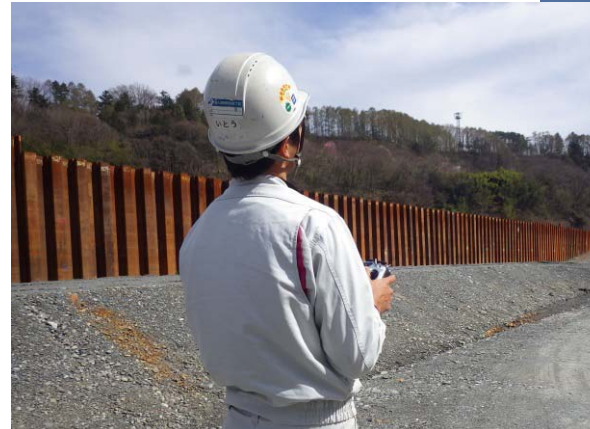
UAVによる測量
