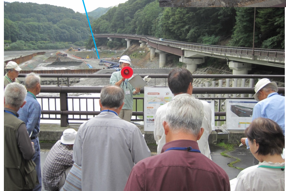
施工中の湖内堆砂対策施設
