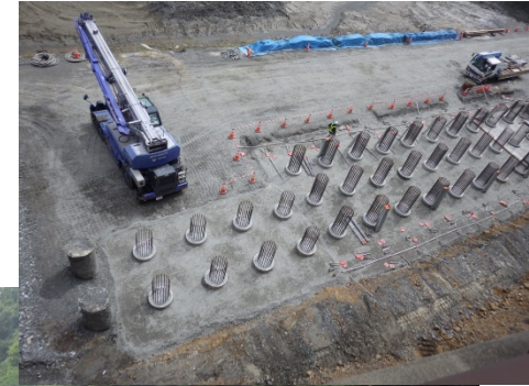
基礎杭の施工状況
