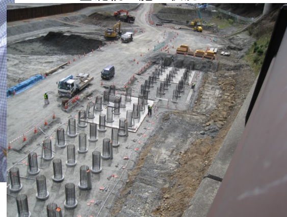
基礎杭の施工状況
