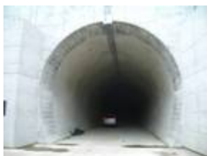
土砂バイパストンネル 吐口正面
