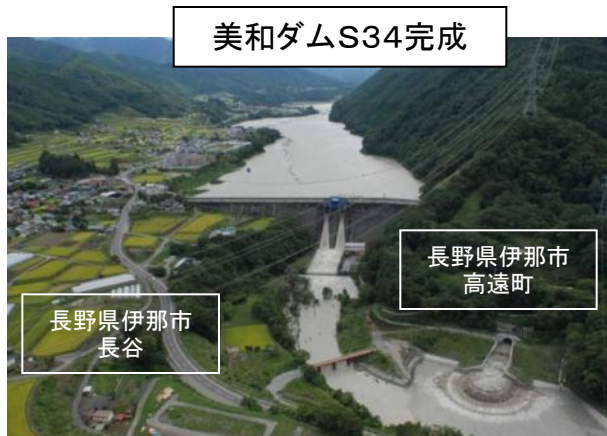
下流より美和ダムを望む 天竜川の流域の概要
