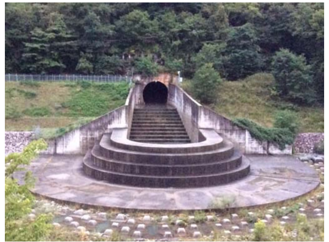
放流していない状況
