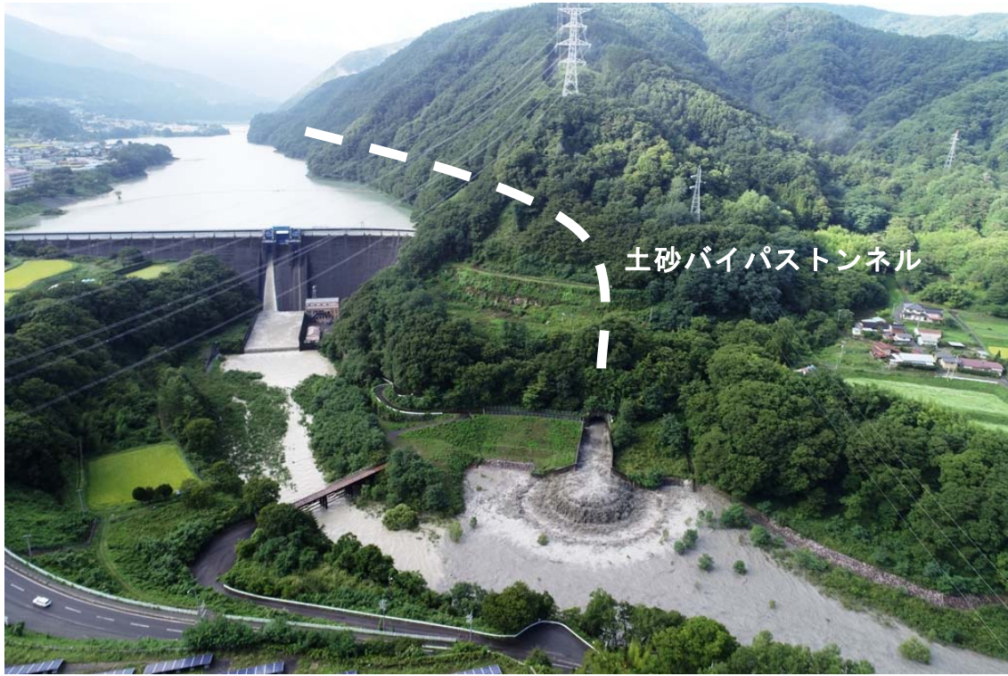
放流中の状況 平成30年9月5日 7時40分 バイパス放流量 毎秒約200m 3
