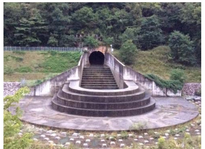
放流していない状況
