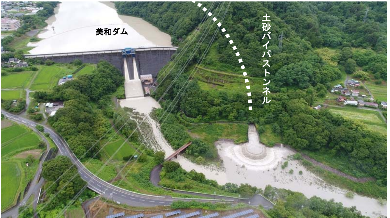
放流中の状況 平成 30 年 7 月 7 日 5 時 8 分 バイパス放流量 毎秒約 100m 3
