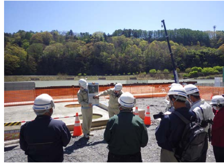
湖内堆砂対策施設工事現場
