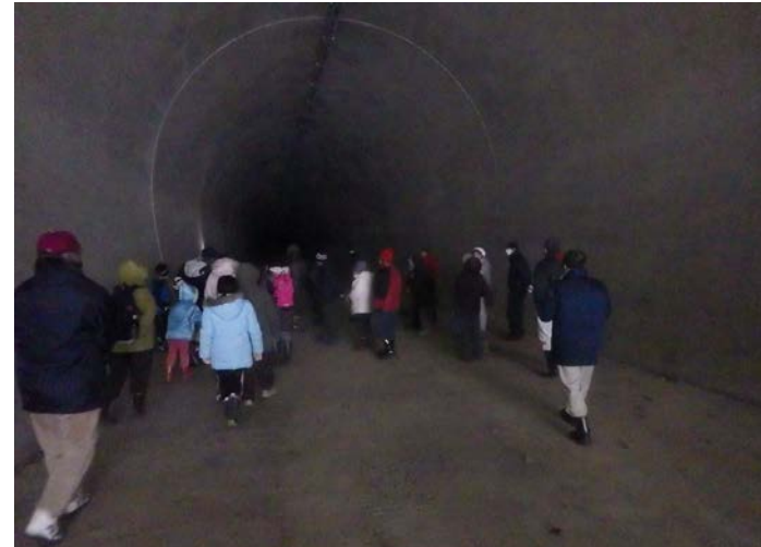
土砂バイパストネル内部
