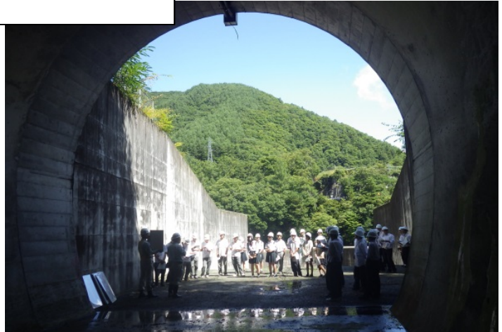
土砂バイパストンネル吐口
