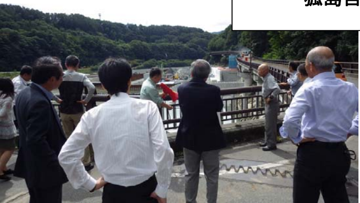
湖内堆砂対策施設工事現場
