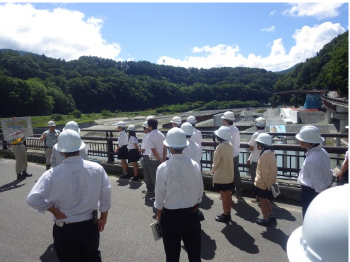
湖内堆砂対策施設工事現場
