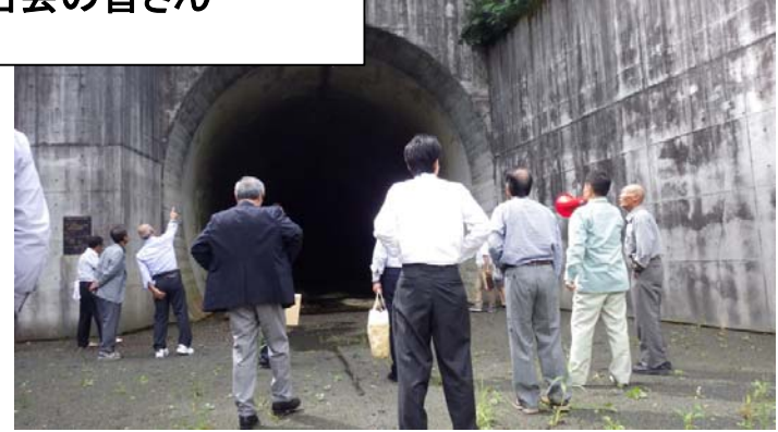
土砂バイパストンネル吐口
