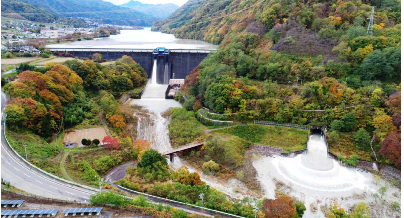
放流中の状況 平成 29 年 10 月 30 日 6 時 31 分 バイパス (右) 放流量 毎秒約 30\text{ m}^3
