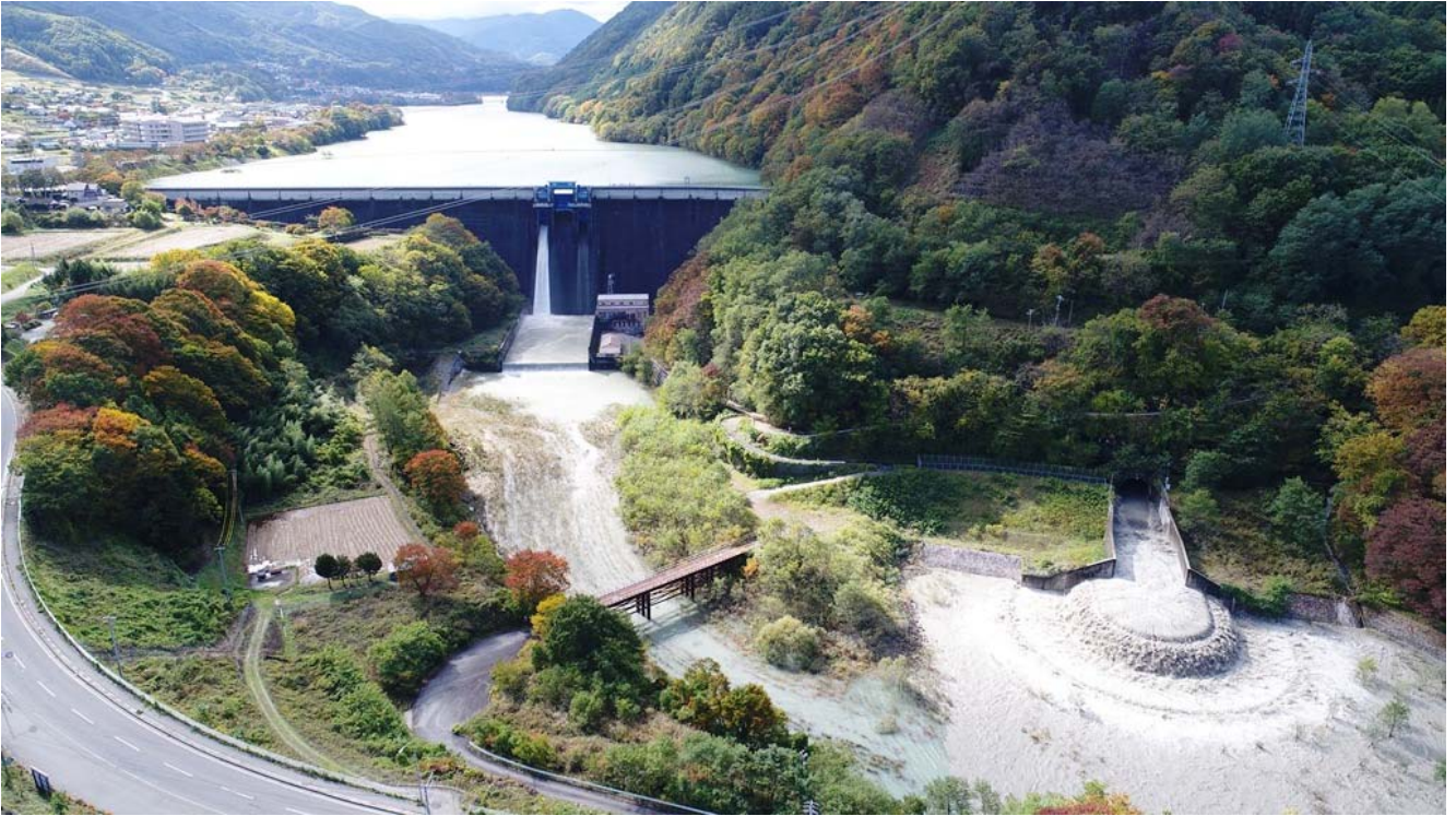
放流中の状況 平成 29 年 10 月 23 日 9 時 43 分 バイパス放流量 毎秒約 1 0 0 m 3
