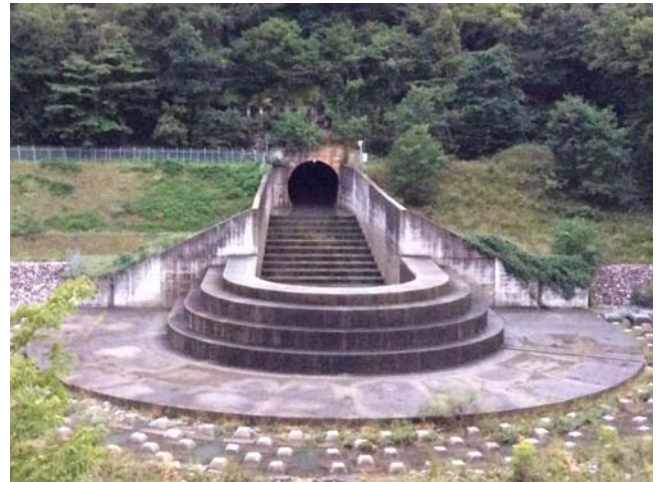
放流していない時の状況
