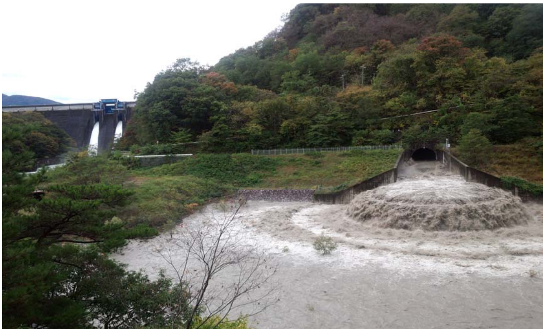
放流中の状況 平成 29 年 10 月 23 日 8 時 00 分 バイパス放流量 毎秒約 137m 3
