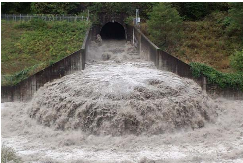
放流中の状況 平成 29 年 10 月 23 日 8 時 00 分 バイパス放流量 毎秒約 137m 3
