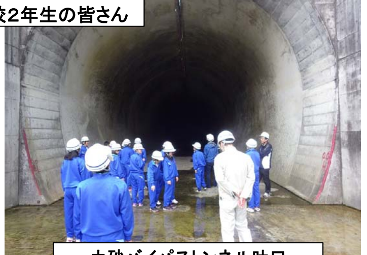
土砂バイパストンネル吐口
