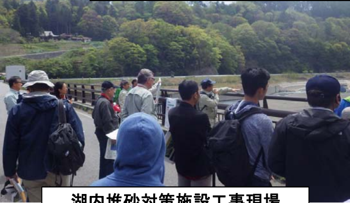
湖内堆砂対策施設工事現場
