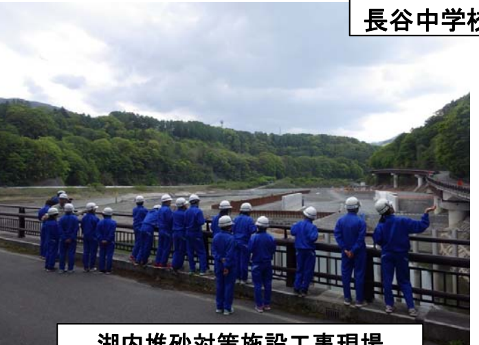
湖内堆砂対策施設工事現場
