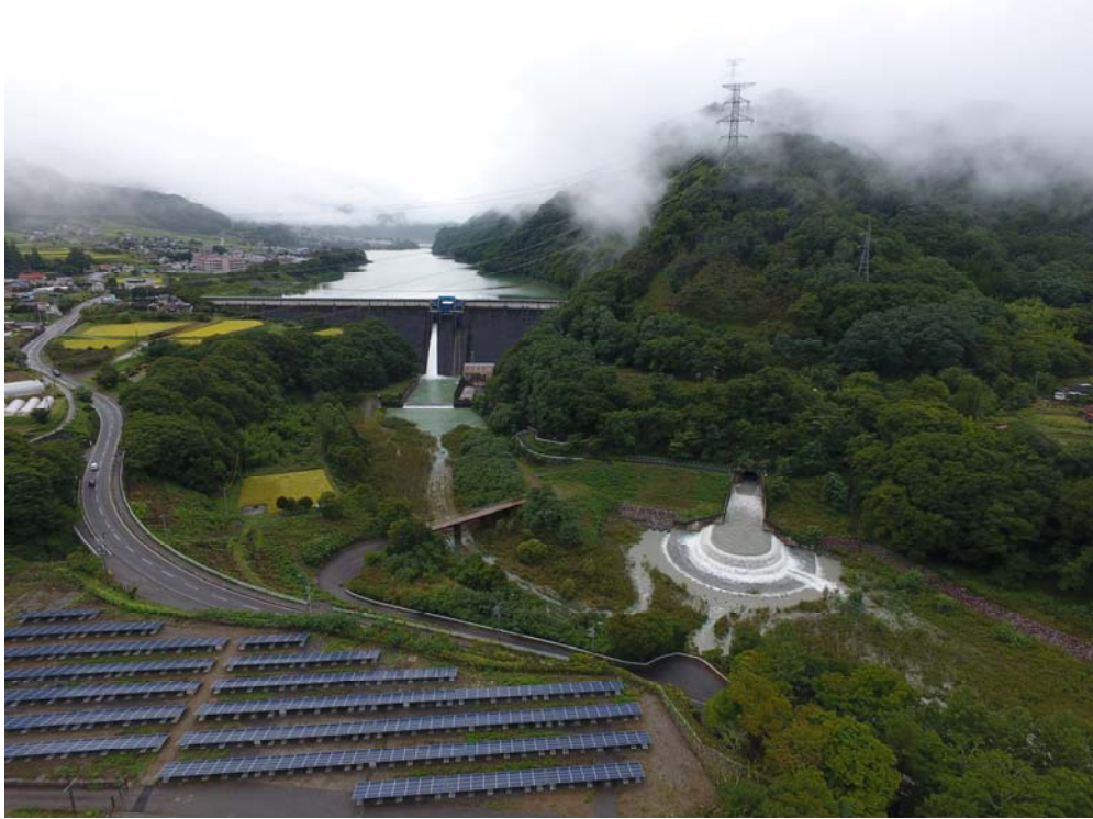
放流中の状況 平成 28 年 9 月 21 日 7 時 50 分 バイパス放流量 毎秒約 20 m 3
