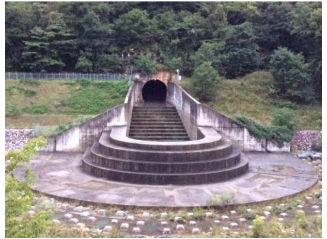
放流していない状況
