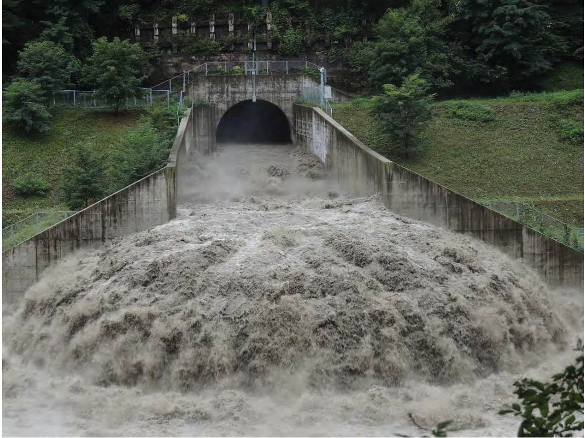
【土砂バイパストンネル 吐口】 放流中の状況 平成25年9月16日15:22撮影 放水量 毎秒176m 3
