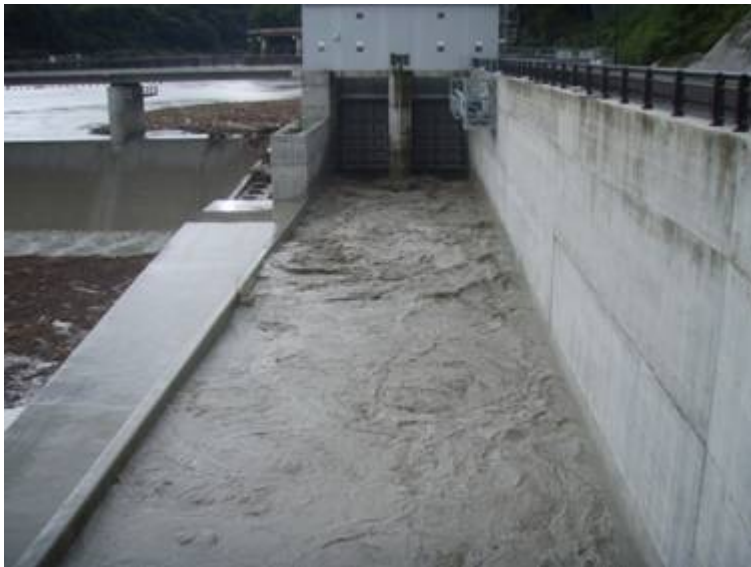
主ゲート・バイパス水路 (9/7 10:10)
