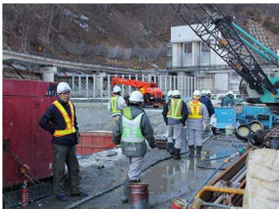
写真：進入路工事の安全点検 「クレーンの作業範囲に注意して施工せよ」
