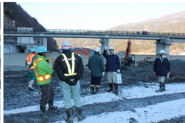
写真：維持作業（掘削）の安全点検 「安全な通路の確保を行おう」
