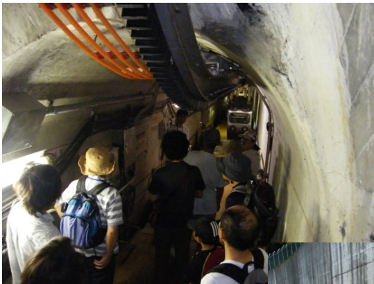
ダム探検 (堤体内見学)
