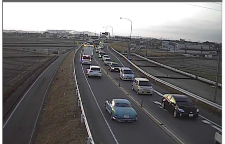
2車線区間の交通状況 和泉IC付近(豊橋方面を望む)
