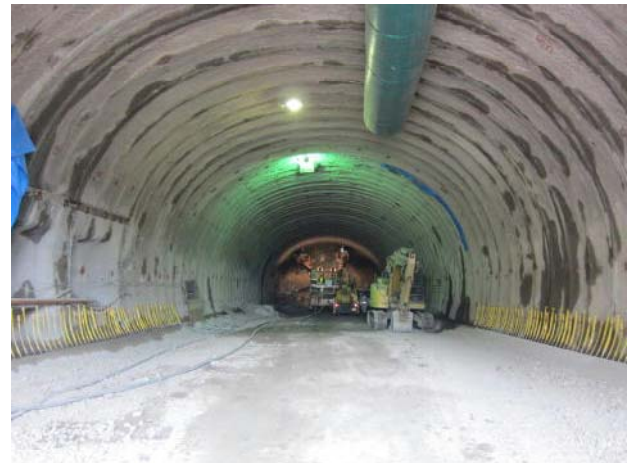
トンネル坑内
