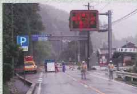
通行規制の様子
