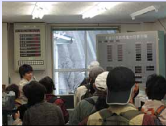
(ダムゲートの操作室を見学)
