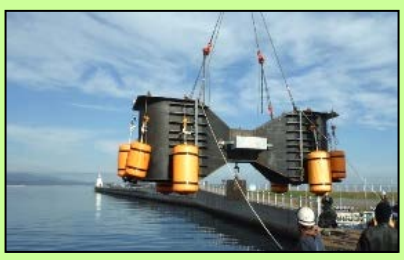
鋼製補強材進水
