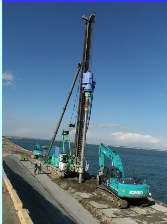
施工イメージ(深層混合処理機)
