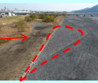
②-1 巨石付き盛り土 さす 砂州工の試験施工
