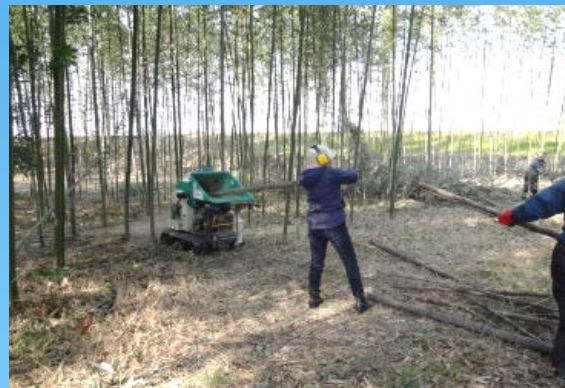
竹林伐採整備作業
