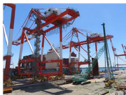
②飛島ふ頭東 R1 岸壁
