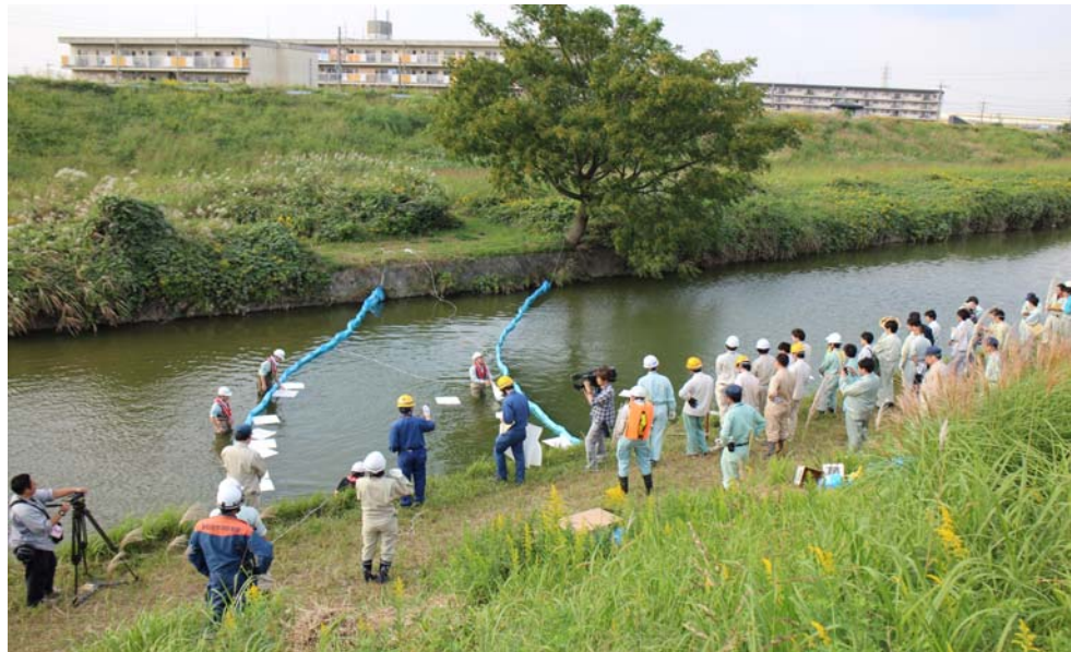
オイルフェンスの設置
