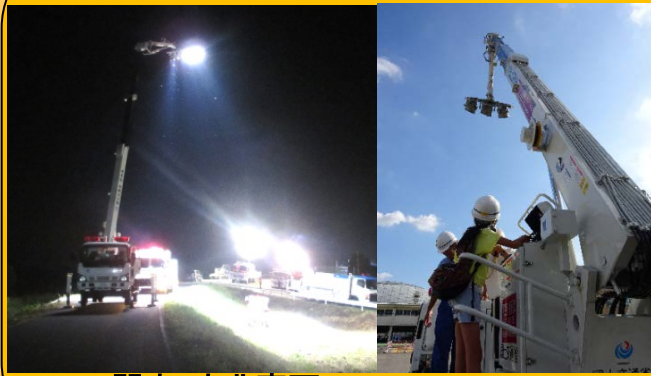
H27関東・東北豪雨での照明作業
