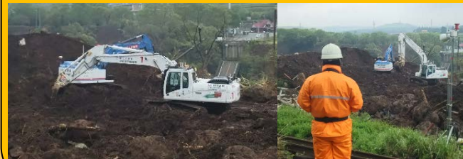
H28熊本地震での作業状況 遠隔操縦状況
