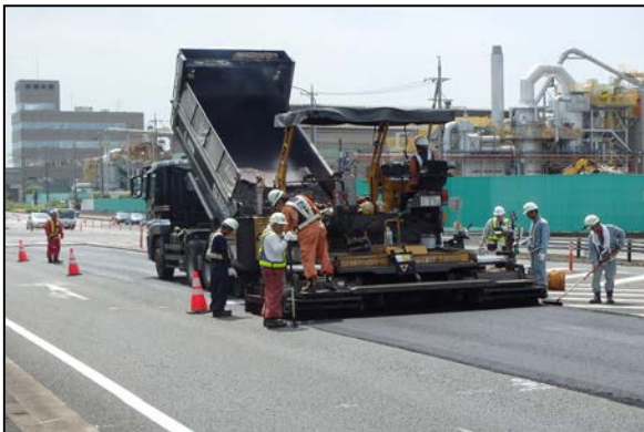
平成 28 年 8 月 17 日実施 国道 155 号（豊田市堤町）での工事風景
