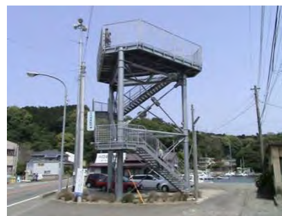
津波避難タワー(静岡県沼津市)
