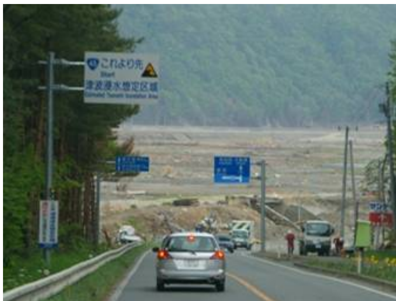
津波浸水想定区域の表示
