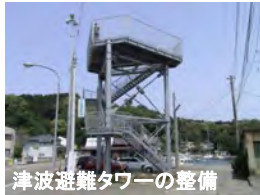
避難施設の整備
