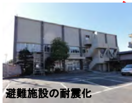
避難施設の整備
