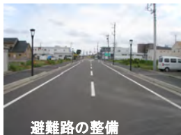
避難路の整備
