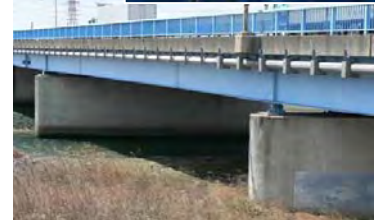
国道 23 号 町屋大橋（三重県桑名市）
