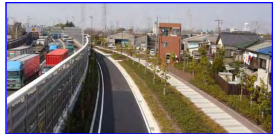
環境施設帯設置例(愛知県名古屋市)
