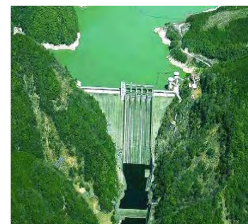
佐久間ダム（昭和31年完成）
