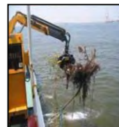
流木回収状況
