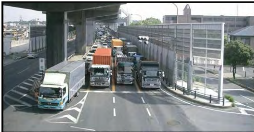
遮音壁設置例(愛知県名古屋市)
