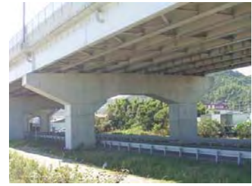
国道 1 号 白須賀高架橋（静岡県湖西市）
