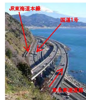
地すべりと併走する重要交通施設
