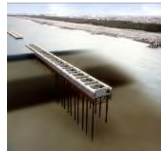
有脚式離岸堤
