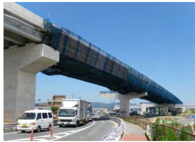
国道23号名豊道路(豊橋東バイパス) 前芝高架橋(仮称)の状況
