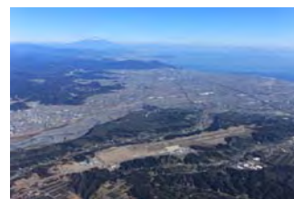
富士山静岡空港 写真提供: 静岡県
