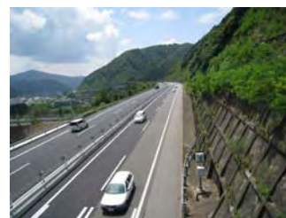
郡上八幡IC～ぎふ大和IC間 4車線化
