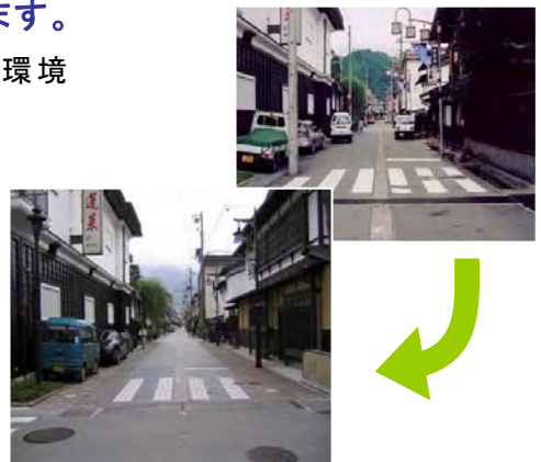
電線地中化・道路の美装化の事例
