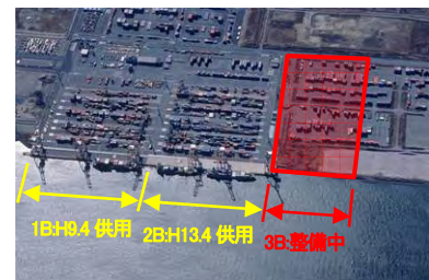
名古屋港 鍋田ふ頭地区 国際海上コンテナターミナル
