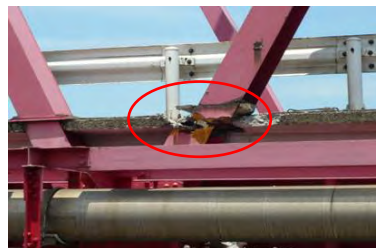
破断の状況(H19.6.20 破断発見)
