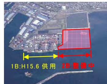
清水港 新興津地区 国際海上コンテナターミナル
