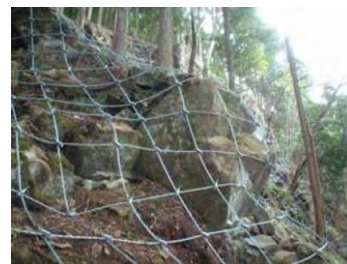
ロープネット張工による対策イメージ (国道 41 号下呂市金山町)
