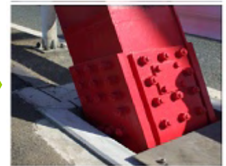
緊急対策を実施(添接板補強)
