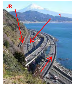
地すべりと併走する重要交通施設
