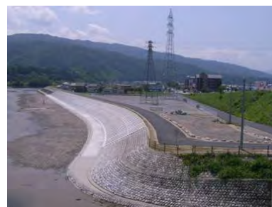
整備後の状況
