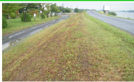
■堤防の様子after
